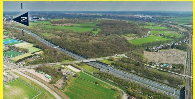
Luchtfoto van de huidige verdiepte A27 ter hoogte van landgoed Amelisweerd.
