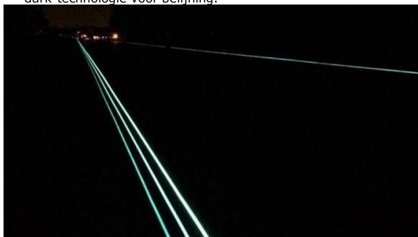
Figuur 18.1: Glow in the dark belijning langs de Weg van de Toekomst bij Oss
