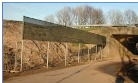
Figuur 7.1: Foto van bouwhekken met worteldoek als tijdelijke vliegroute voor vleermuizen.
