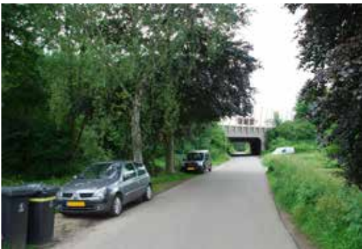
↑ De bestaande onderdoorgang Voordorpsedijk, gezien vanuit Voordorp.
