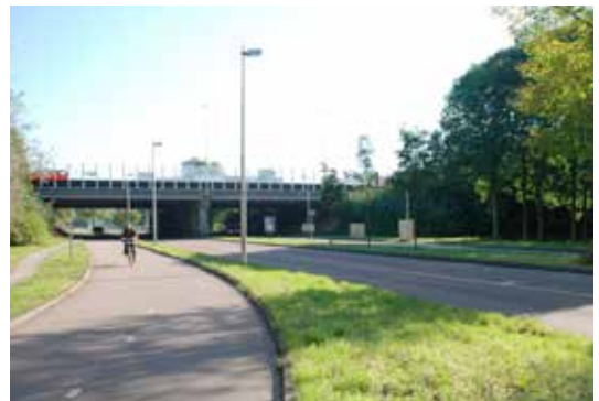
↑ De bestaande onderdoorgang ter hoogte van de Archimedeslaan, gezien vanaf Rijnsweerd.
