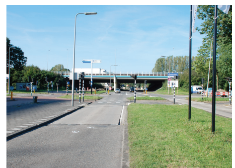
Boven: Bestaande onderdoorgang ter hoogte van de Weg tot de Wetenschap, gezien vanaf de Uithofzijde. Links: een visualisatie van de mogelijke vormgeving van het viaduct na verbreding van de A27.
