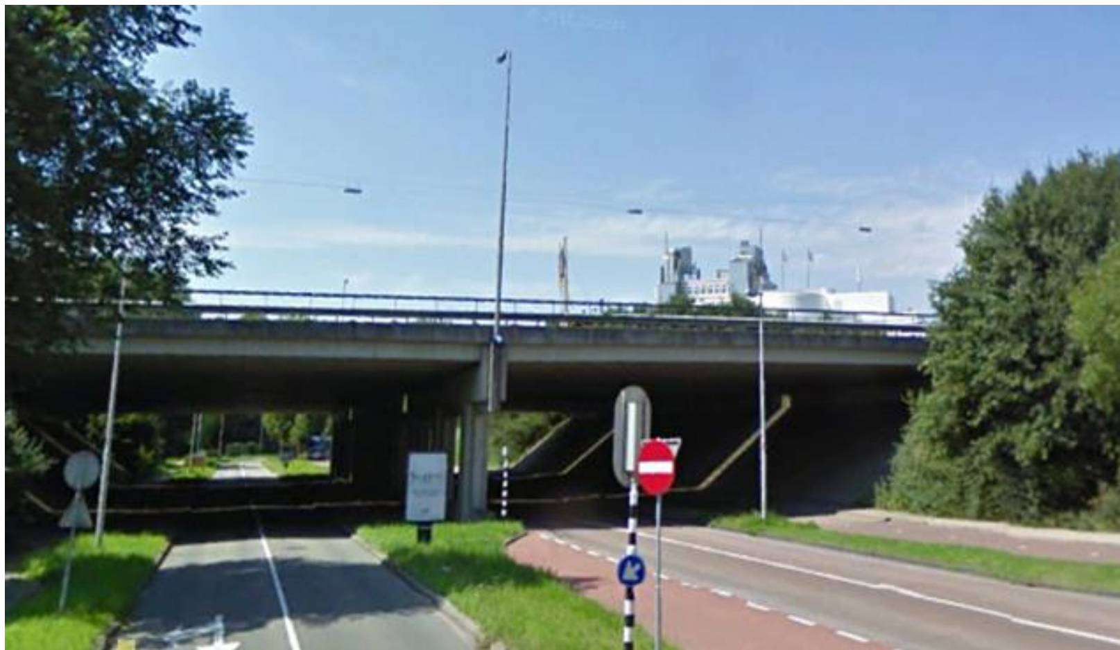
Afbeelding: Viaduct Archimedeslaan (bron: Google Streetview)
