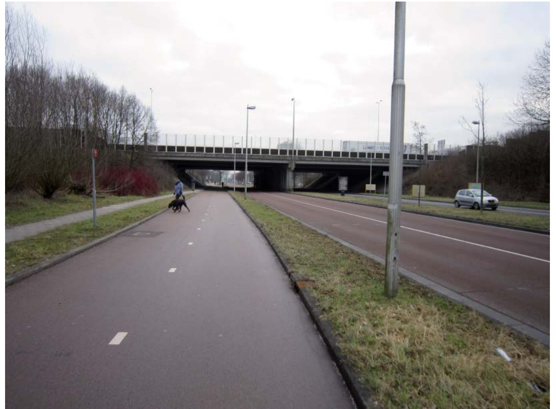
Huidige situatie onderdoorgang Archimedeslaan
