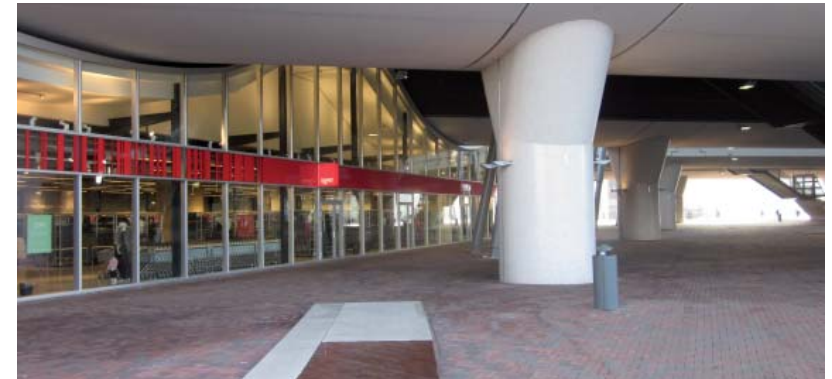
Referentie functies onder het viaduct
