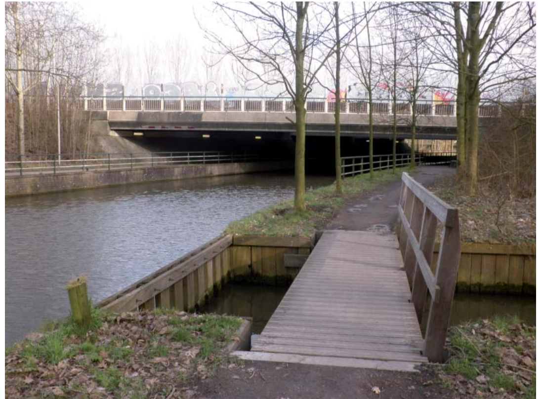
Huidige situatie onderdoorgang Kromme Rijn
